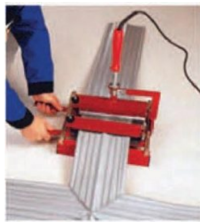
Сварка гидропонок между собой с помощью кондуктора
