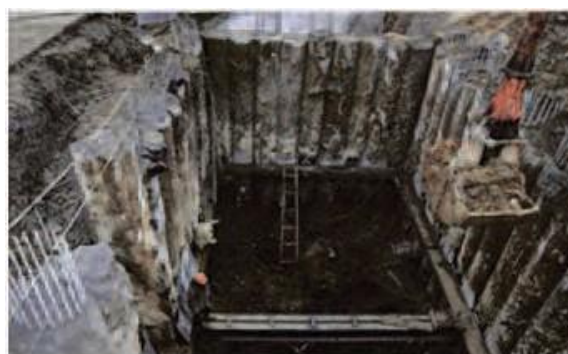
Устройства «стены в грунте» буросекущими сваями
